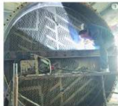
施工现场-胀好的管板
