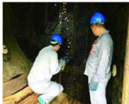
施工现场-自动拔管
